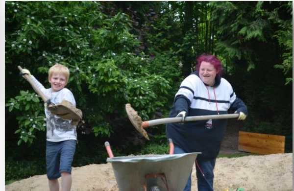
Mama und Sohn gemeinsam beim Sand schaufeln. (Fundament des Steinwalls)
